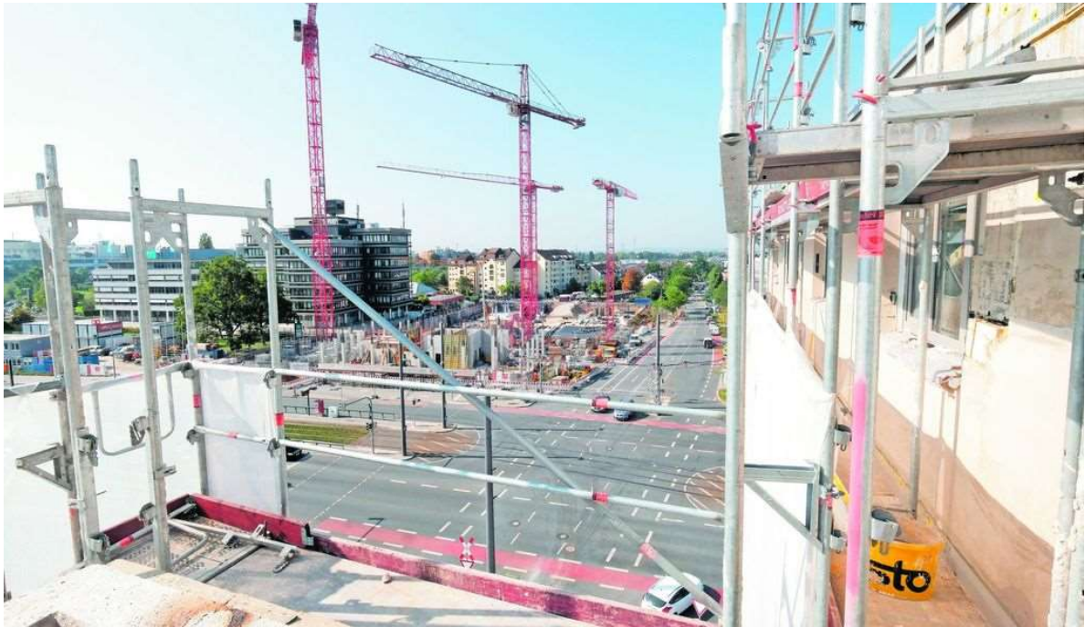
BAUSTELLE NEBEN BAUSTELLE: Aus dem siebten Stock des „Kilian1“ ist der Bau von „TheOne“ gut zu erkennen. (Foto: Roland Fengler)
